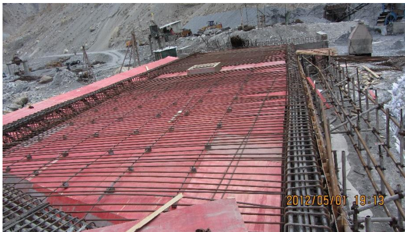
土台上泥浆池 concrete sump
